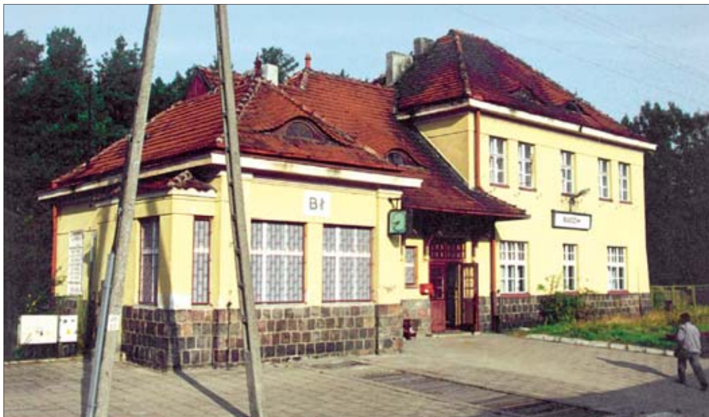
8. Przykład typowego dworca okresu międzywojennego. Stacja Błędzin – północny odcinek magistrali węglowej (Nowawieś Wielka – Bydgoszcz Wschód – Gdynia).
