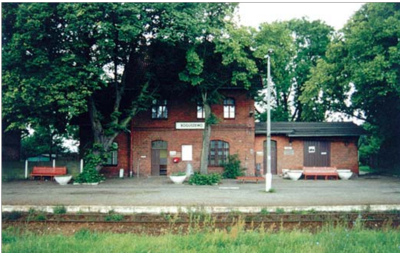
6. Budynek dworca zespolony z magazynem na małej stacji kolejowej (Boguszewo, linia Grudziądz – Jabłonowo Pomorskie). Uwagę zwraca dbałość o właściwe urządzenie zieleni.
