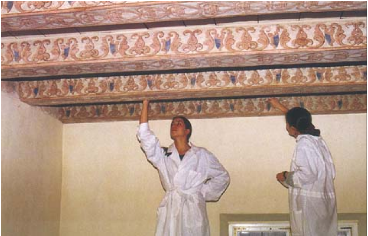
16. Prace konserwatorskie stropów polichromowanych pałacu w Wilanowie. Fot. Archiwum ASP w Warszawie.
