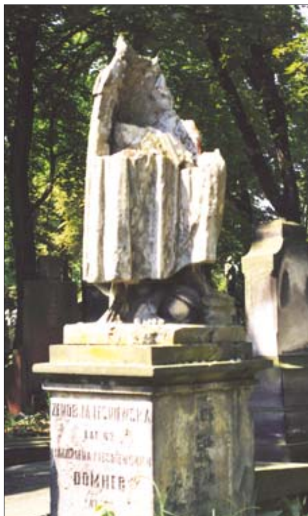
5. Nagrobek Pawła Leśniewskiego na warszawskich Powązkach. Rozpad rzeźby betonowej pod wpływem czynników atmosferycznych.
