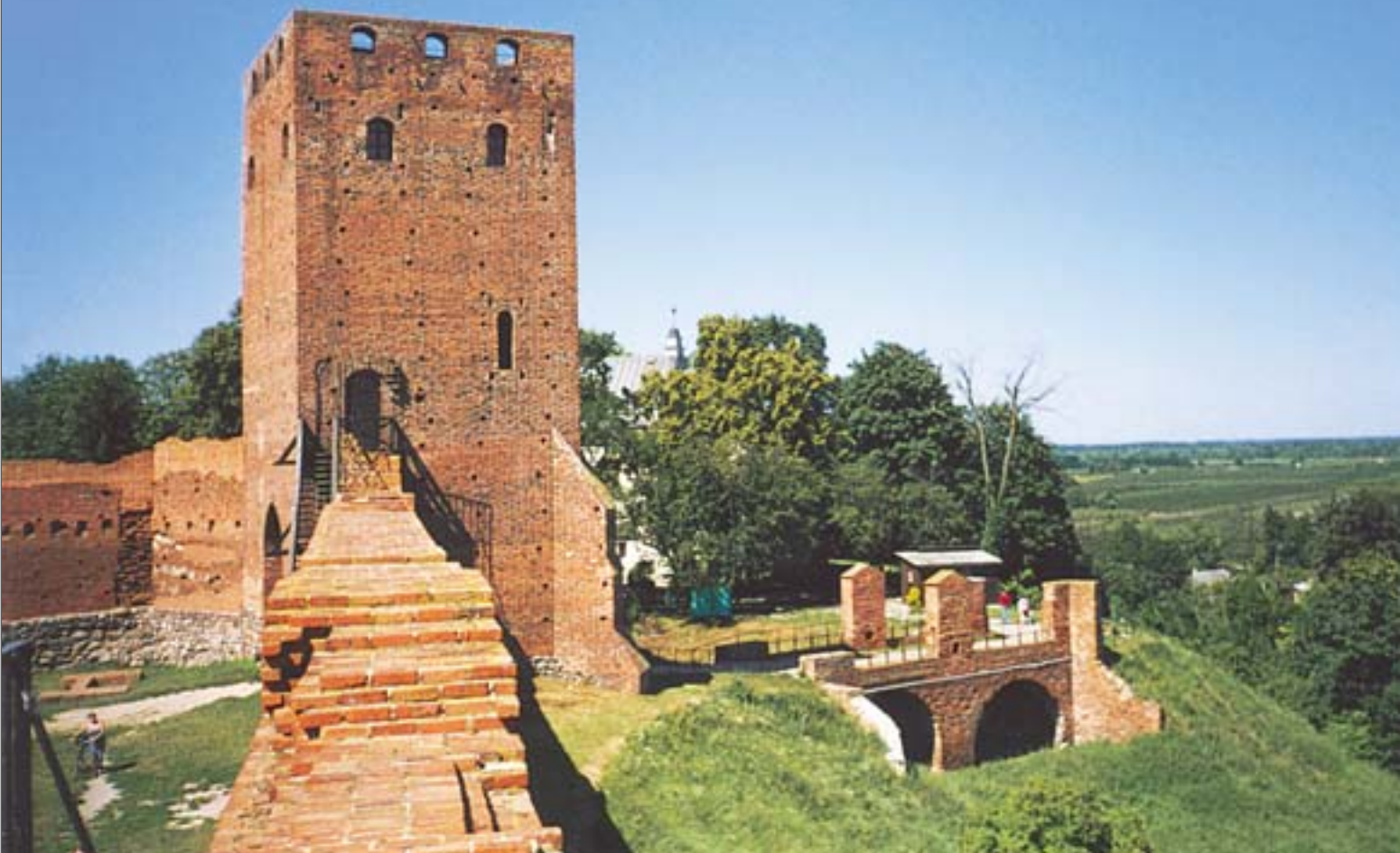
10. Zamek Książąt Mazowieckich w Czersku (XIV w.). Widok z wieży wschodniej na wieżę bramną. Widoczne ceglane arkady mostu ufundowanego przez marszałka Franciszka Bielińskiego w XVIII w. (powstał w miejscu zwodzonego mostu drewnianego, opuszczanego z wieży bramnej), 2004 r.
