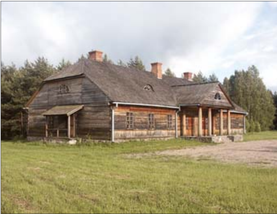
2. Dwór ziemiański z 1818 r., konstrukcja zrębowa, z Bobry Wielkiej (woj. podlaskie), obecnie w Białostockim Muzeum Wsi w Osowiczach. Fot. K. Kulesza. 2. Gentry manor house from 1818, framework construction from Bobra Wielka (voivodeship of Podlasie), today in the Białystok Village Museum in Osowicze. Photo: K. Kulesza.
