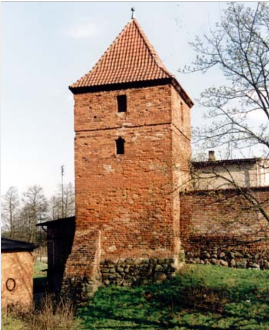
5. Wieża w narożniku północno-wschodnim murów miejskich (odcinek nr 2). Widok elewacji północnej. Fot. P. Tuliszewski, 2001 r.
