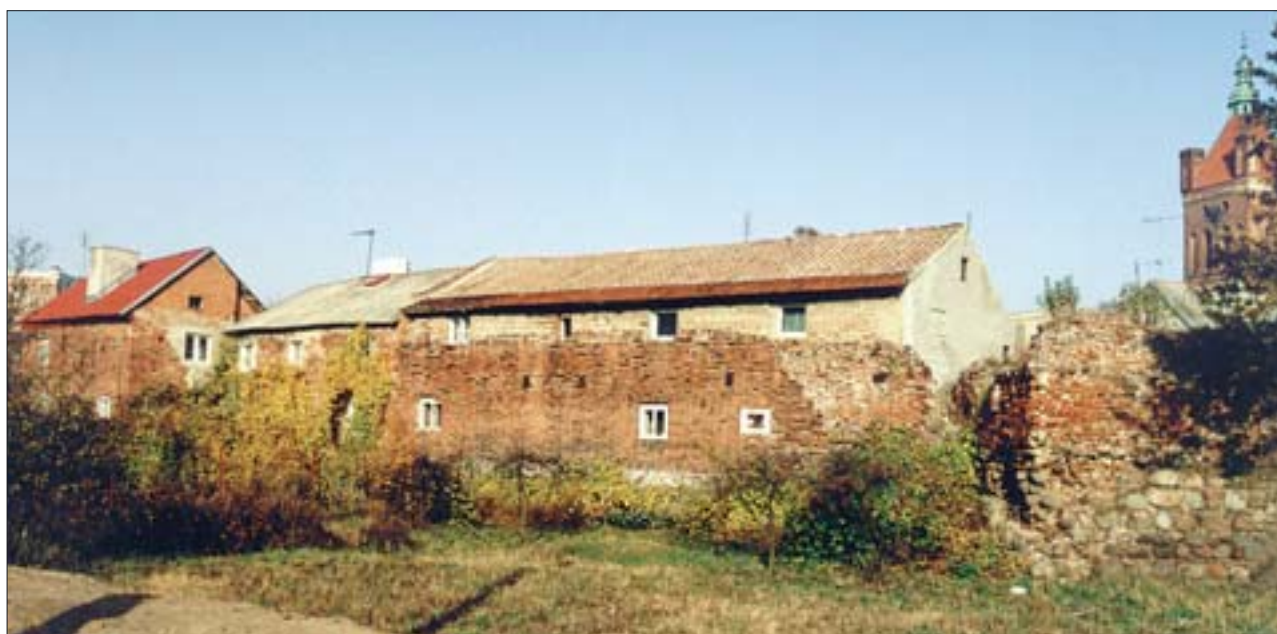
13. Południowo-zachodni ciąg murów, widoczna zewnętrzna strona odcinków od nr. 21 do 23. Mury nadbudowane i obudowane po stronie wewnętrznej bryłami domów mieszkalnych. Fot. K. Milanowski, 2000 r.
