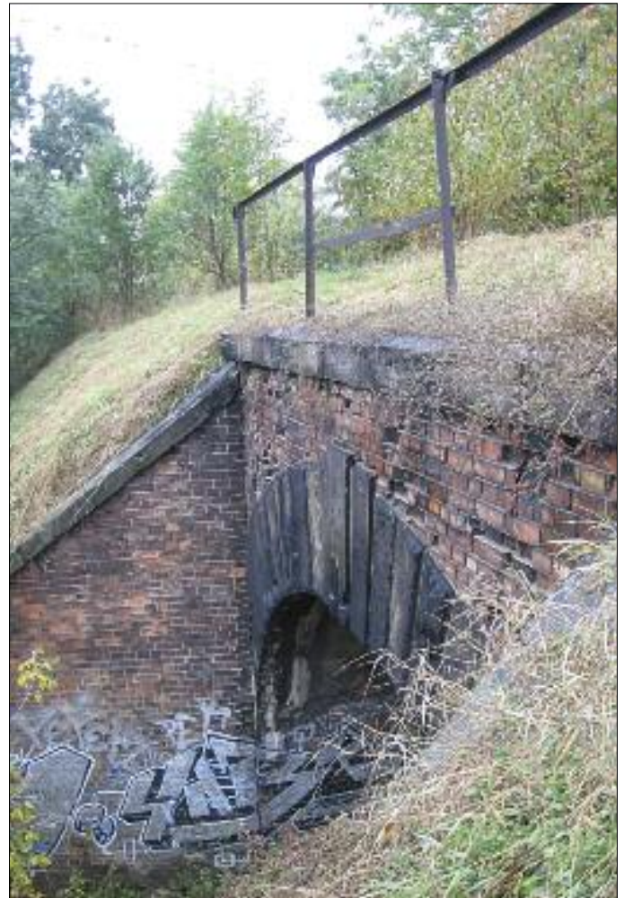
5. Widok na mur oporowy i licowanie fasady płytami z piaskowca.
