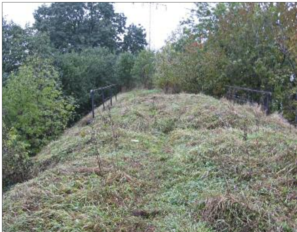
6. Widok na zachowany fragment nasypu kolejowego nad wiaduktem.
