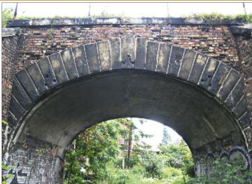
12. Widok na sklepienie żelbetowe. 12. View of the reinforced concrete vault.
