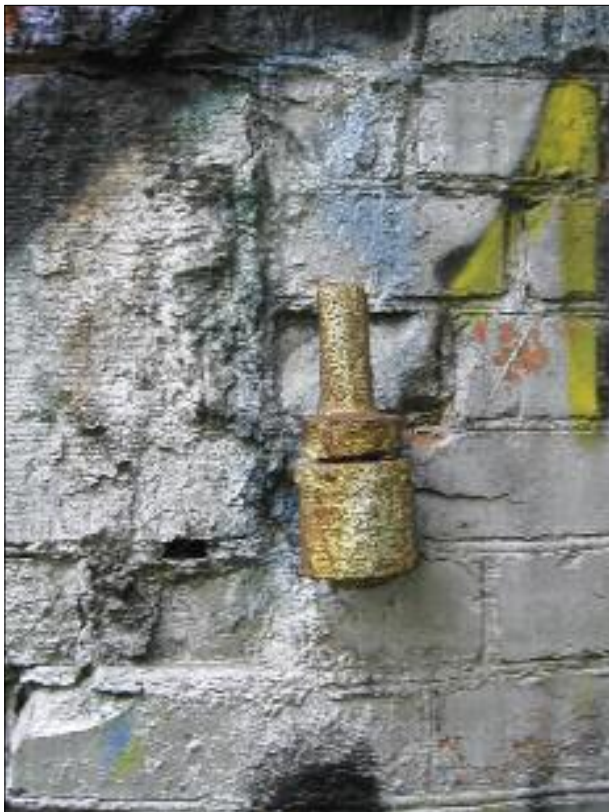
4. Zawias czopowy nieistniejącej bramy drewnianej umieszczonej niegdyś w świetle wiaduktu.
