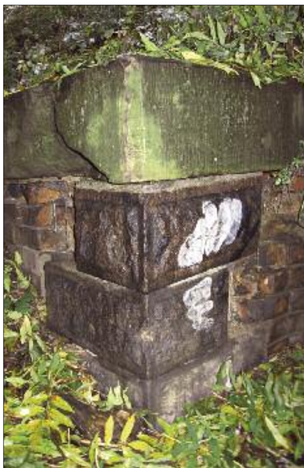
3. Licowanie zakończenia muru oporowego. 3. Facing on the end of a retaining wall.
