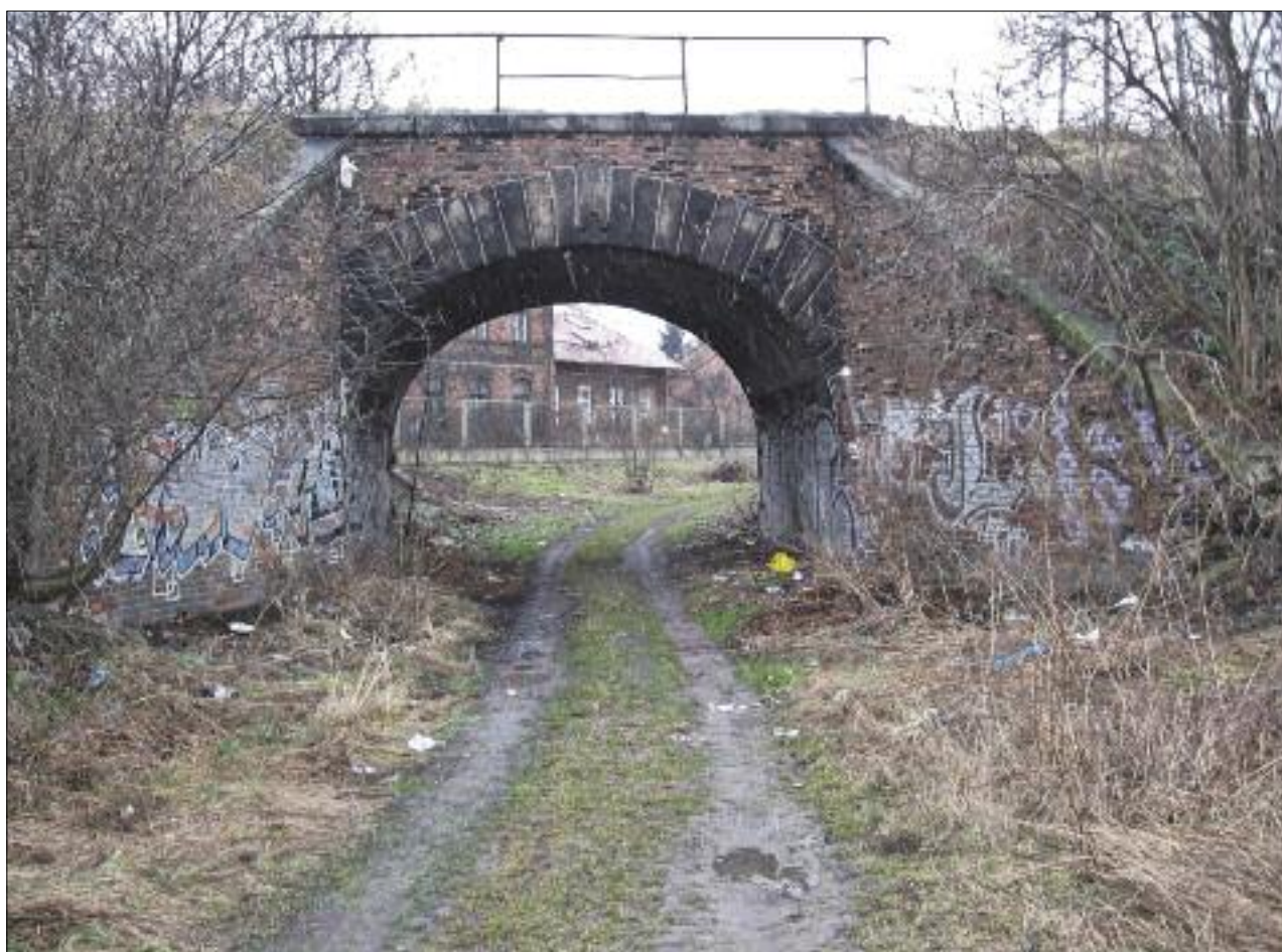
1. Wiadukt paraboliczny – widok od strony stacji Warszawa Zachodnia. Wszystkie fot. K. Duszczyk.
