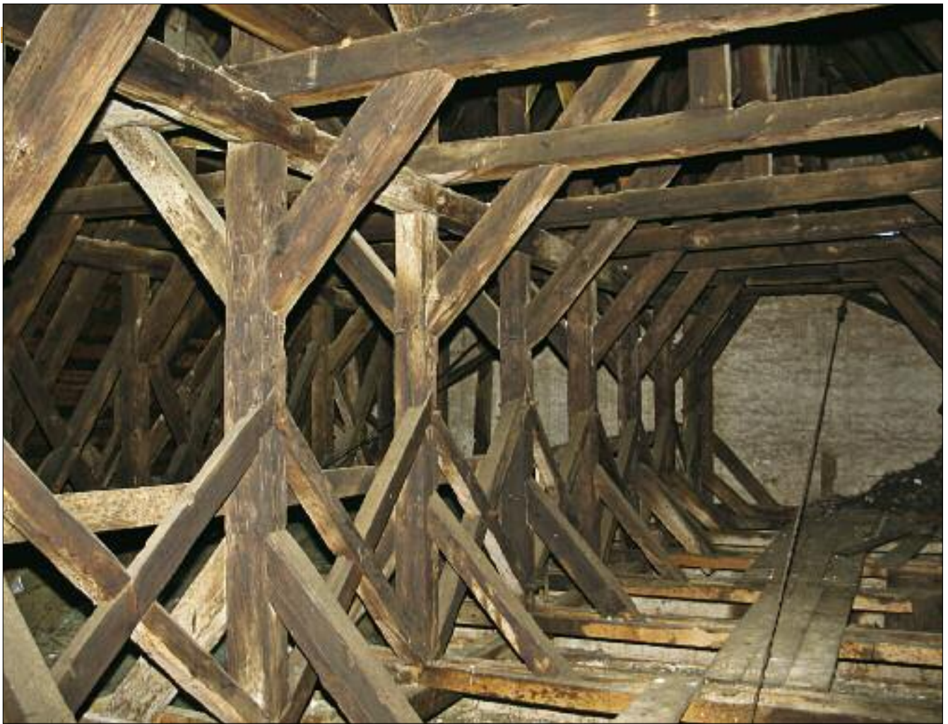
4. Ceglów, kościół pw. św. Jana Chrzciciela, widok centralnej ramy storczykowej więźby nad prezbiterium, prawdopodobnie XVI w. 4. Ceglów, church of St. John the Baptist, view of the frame of the king-post rafter framing above the presbytery, probably sixteenth century.
