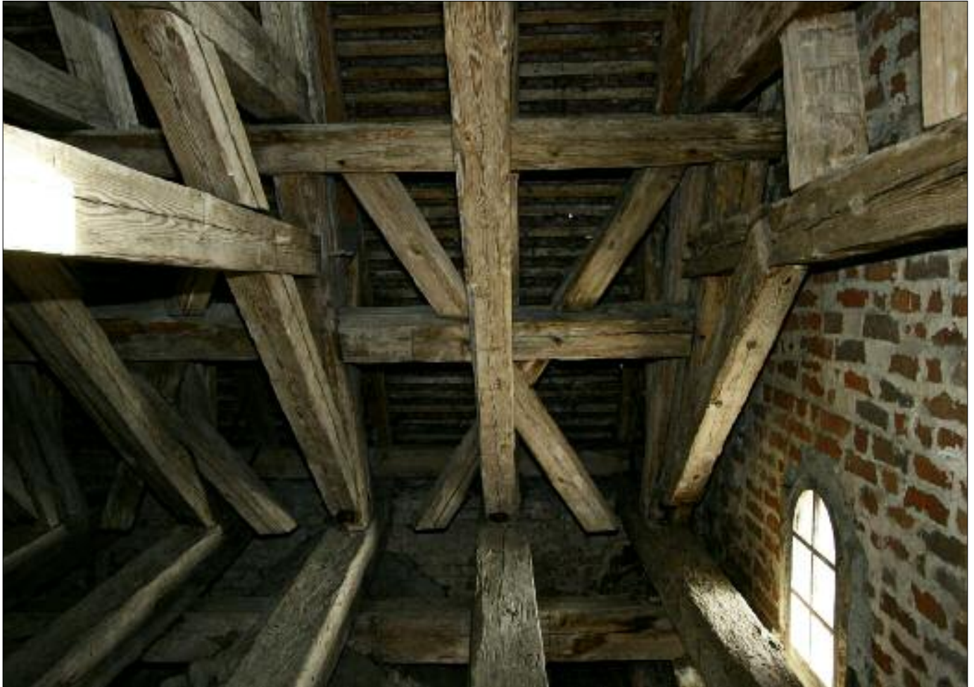
15. Pszczonów, kościół pw. Wszystkich Świętych, widok bocznej ramy stolcowej więźby nad nawą, XVII-XVIII w. 15. Pszczonów, church of All Saints, view of the side frame of the queen-post rafter framing above the nave, seventeenth-eighteenth century.
