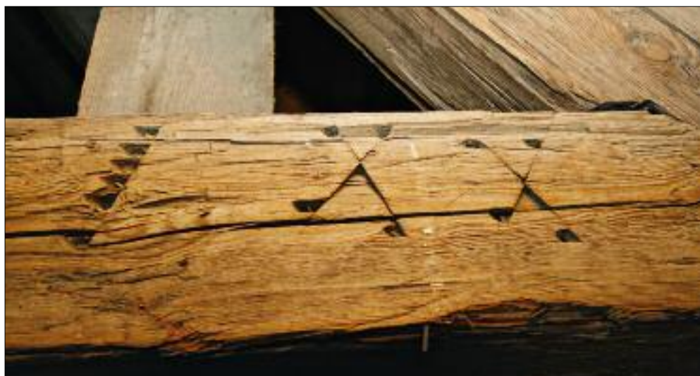
14. Przasnysz, kościół pobernardyński pw. św. św. Jakuba i Anny, ciesielskie znaki montażowe na elemencie konstrukcji więźby nad nawą.
