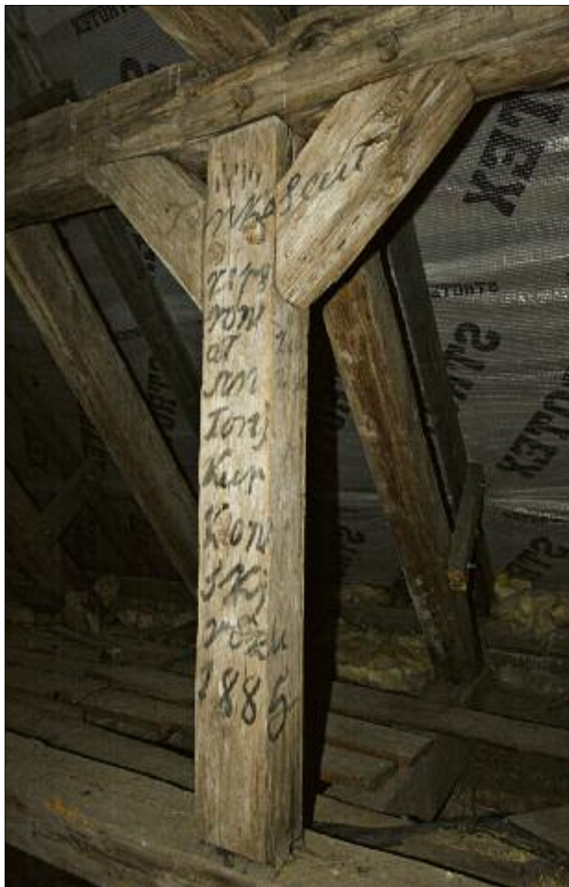
1. Ratowo, kościół pw. św. Antoniego, inskrypcja na stolcu konstrukcji więźby nad nawą. Wszystkie fot., rys. i oprac. M. Warchoł.
