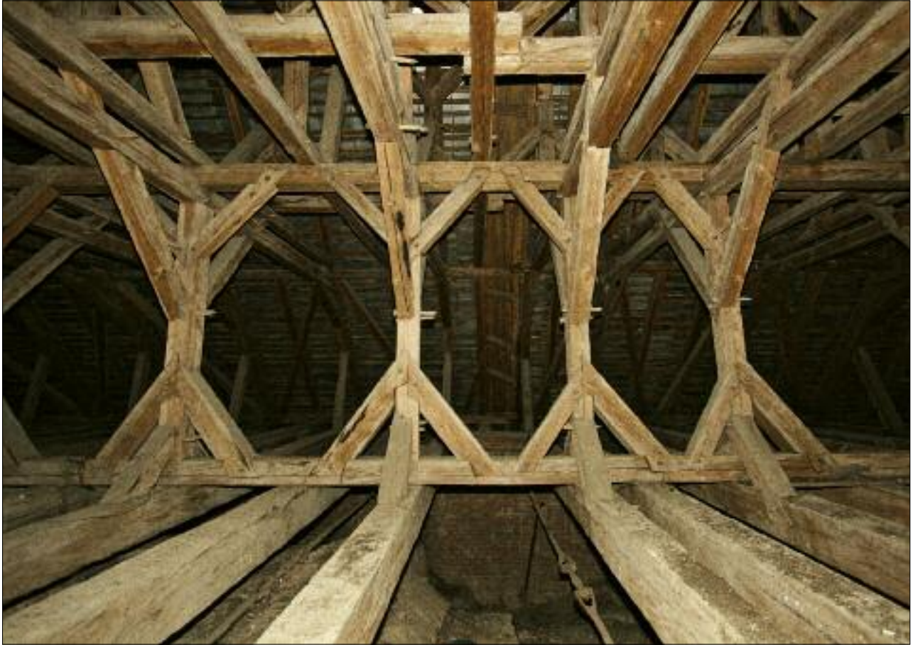
16. Głuchów, kościół pw. św. Wacława, widok centralnej ramy stolcowej więźby nad nawą i prezbiterium, 2. poł. XVIII w. 16. Głuchów, church of St. Wacław (Wenceslas), view of the central frame of the queen-post rafter framing above the nave and the presbytery, second half of the eighteenth century.
