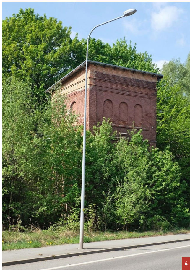
4 Wieża nad szybem Powietrznym, 2022 rok, fot. W. Wrona-Gaj 'Air' shaft, 2022, photo W. Wrona-Gaj
