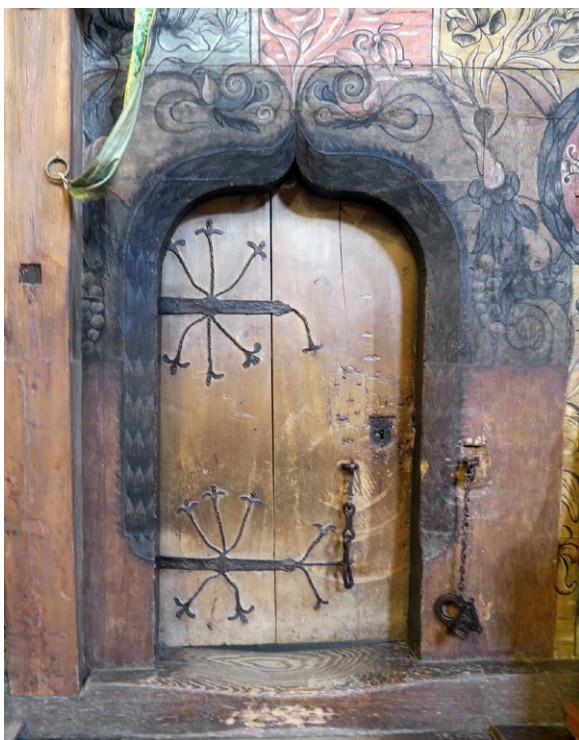
5 Drzwi do zakrystii (awers i rewers) kościoła w Bliznem, zachowane z kompletnym systemem okuć, zamkiem i kłódką (z datą 1648). Fot. J. Stęchły
