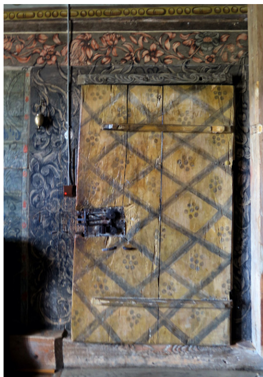
5 Drzwi do zakrystii (awers i rewers) kościoła w Bliznem, zachowane z kompletnym systemem okuć, zamkiem i kłódką (z datą 1648). Fot. J. Stęchły
