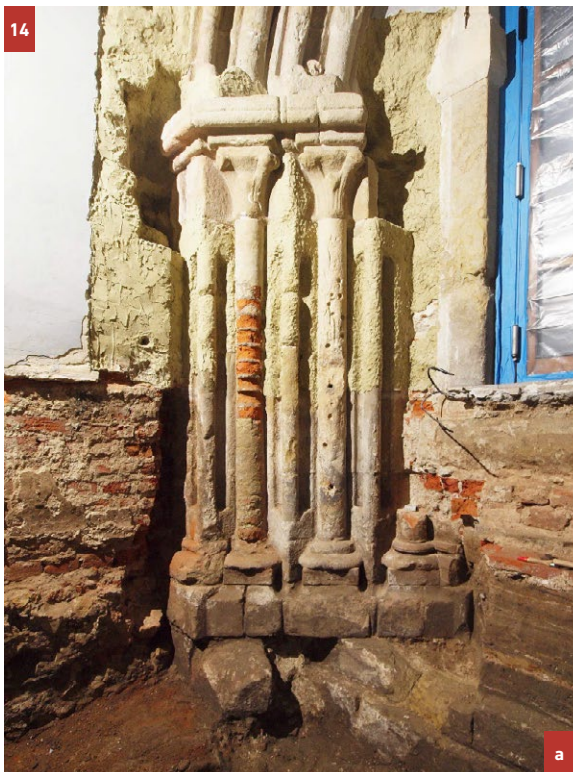
14 Lewe ościeże portalu z widocznym brakiem stabilnego podparcia i z dobrze zachowanymi profilami bazy usuniętej wewnętrznej kolumnienki. Fot. A. Bojęś-Białasik, 2020
