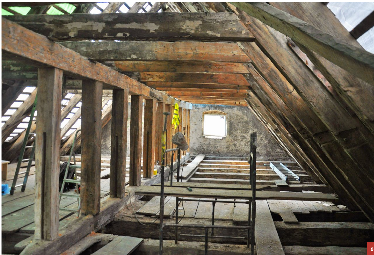
6 Więżba dachowa kamienicy – widok w kierunku zachodnim. Fot. U. Schaaf, 2023 Roof truss of the townhouse – view looking westwards. Photo: U. Schaaf, 2023
