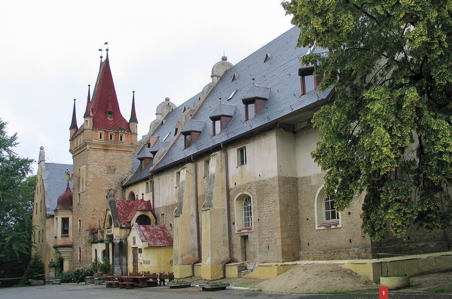
1 Elewacja południowa zamku w Górczce z kamiennym wątkiem romańskim pochodzącym z pierwszej fazy budowy. Fot. K. Stala
