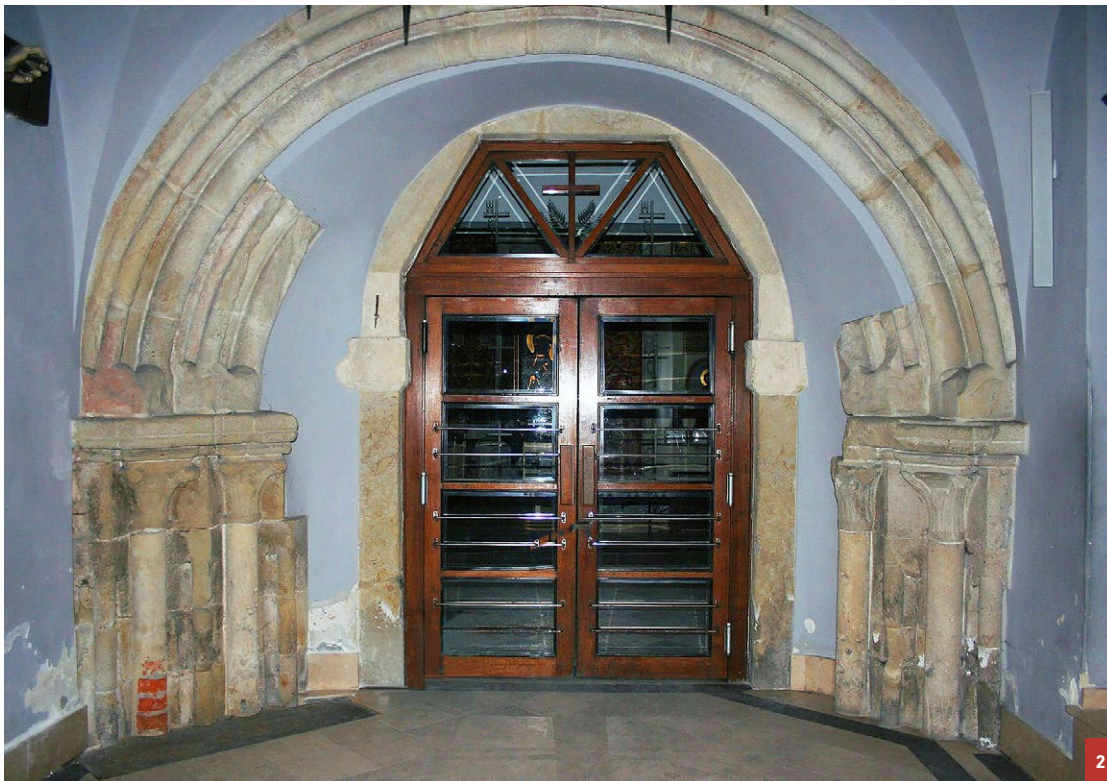
2 Stan portalu w 2018 roku przed rozpoczęciem prac badawczych i konserwatorskich. Fot. A. Bojęś-Białasik, 2018
