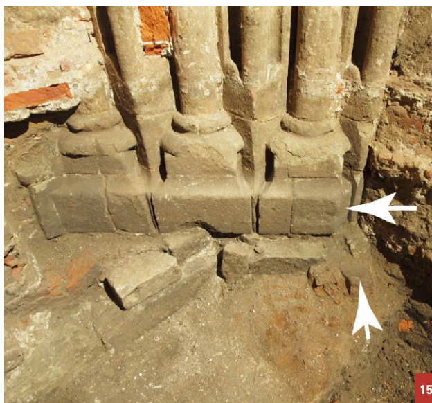
14 Lewe ościeże portalu z widocznym brakiem stabilnego podparcia i z dobrze zachowanymi profilami bazy usuniętej wewnętrznej kolumnienki. Fot. A. Bojęś-Białasik, 2020
