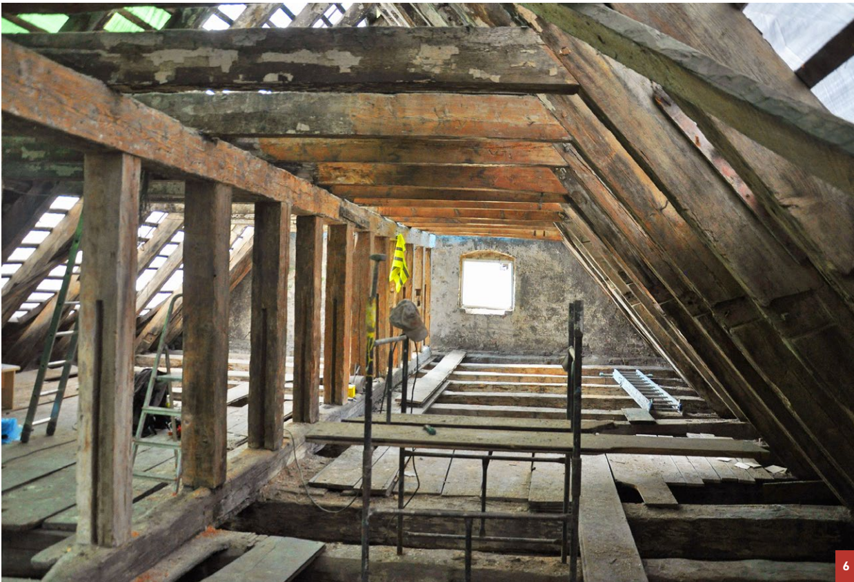
6 Więźba dachowa kamienicy – widok w kierunku zachodnim. Fot. U. Schaaf, 2023 Roof truss of the townhouse – view looking westwards. Photo: U. Schaaf, 2023
