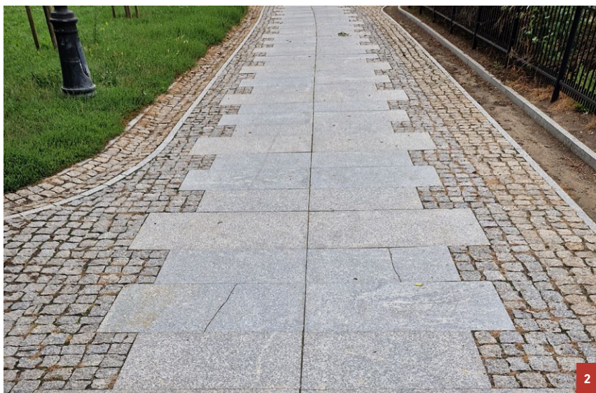
2 Zastosowanie pasa z płyt granitowych. Fot. Piotr Gryszpanowicz
