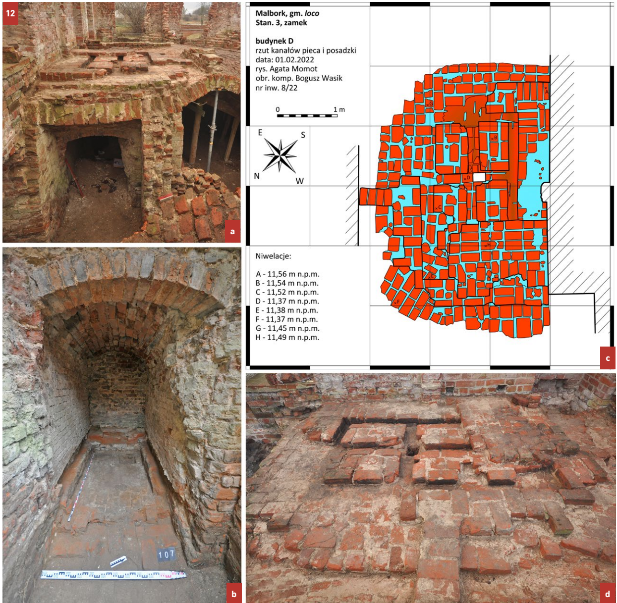
12 Piec w południowej części budynku I.6 (stan w 2022 roku): a – widok ogólny od wschodu na komorę i kanały podszkawkowe na parterze przed odbudową sklepienia piwnicy, b – wewnątrz komory (widok od wschodu); c – rzut poziomy kanałów podposadzkowych z fragmentem ceglanej posadzki; d – widok od północy na kanały i fragment zachowanej posadzki. Fot. B. Wasik (a, b, d), Rys. Agata Momot, oprac. Bogusz Wasik (c)
