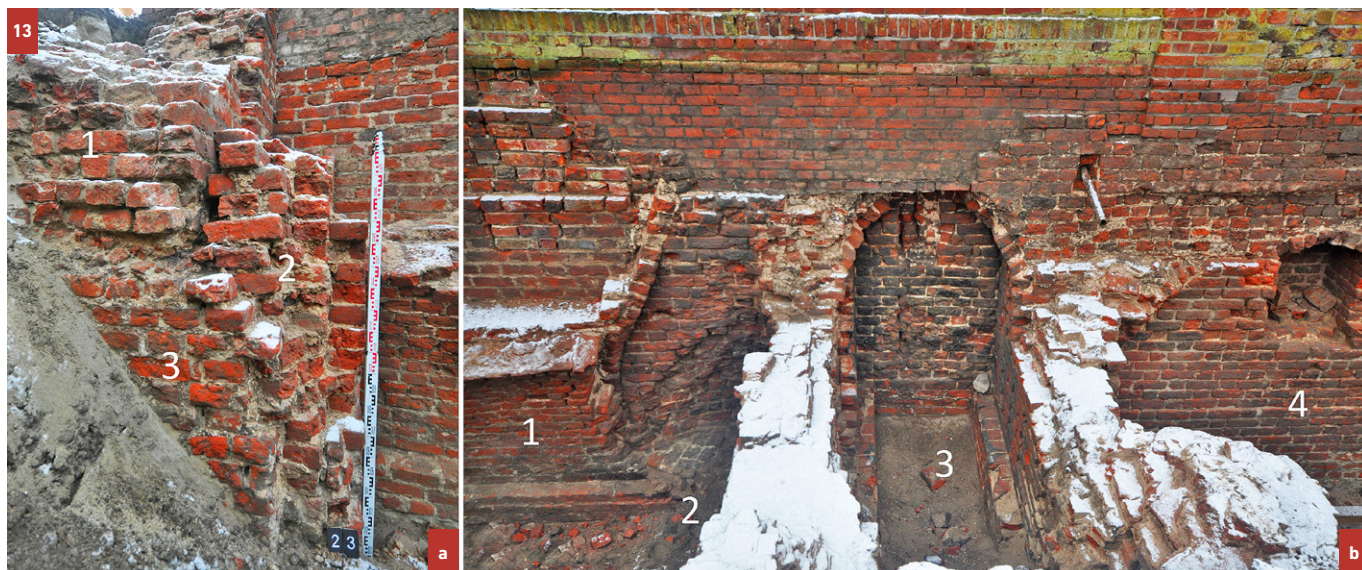
13 Pozostałości piwnic budynku I.7 (widok od północy, stan w 2021 roku). Fot. Bogusz Wasik a) Ściana wschodnia w świetle szyi piwnicznej: 1 – pierwotny fundament (wraz ze stopą na warstwie gruzu ceglanego z piaskiem) budynku przed podpiwniczeniem; 2 – dostawiona, głębiej posadowiona wschodnia ściana piwnicy z oporem sklepienia; 3 – głębiej posadowiona od pierwotnego fundamentu i dostawiona południowa ściana szyi piwnicznej b) Widok ogólny na centralną część piwnic: 1 – dostawiony do szczytu budynku I.6 opór sklepienia piwnicy wschodniej; 2 – wkuty w starsze mury kominek; 3 – piec z wcześniejszego etapu; 4 – piwnica zachodnia
