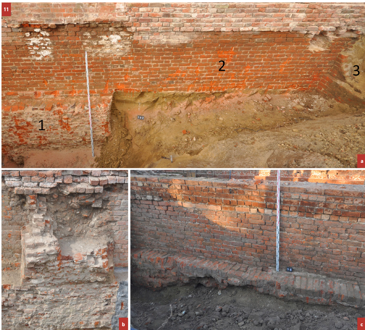
11 Wybrane odcinki fundamentów ścian wschodnich zabudowań ciągu (widok od wschodu) odsłonięte podczas nadzoru archeologicznego w latach 2021–2022: a – północna część fundamentu budynku I.6 z częścią podpiwniczoną (1) i niepodpiwniczoną (2) oraz fundamentem północnego muru ogrodzenia podwórza (3); b – pozostałość kosza okna piwnicy; c – fundament budynku I.4. Fot. Bogusz Wasik
