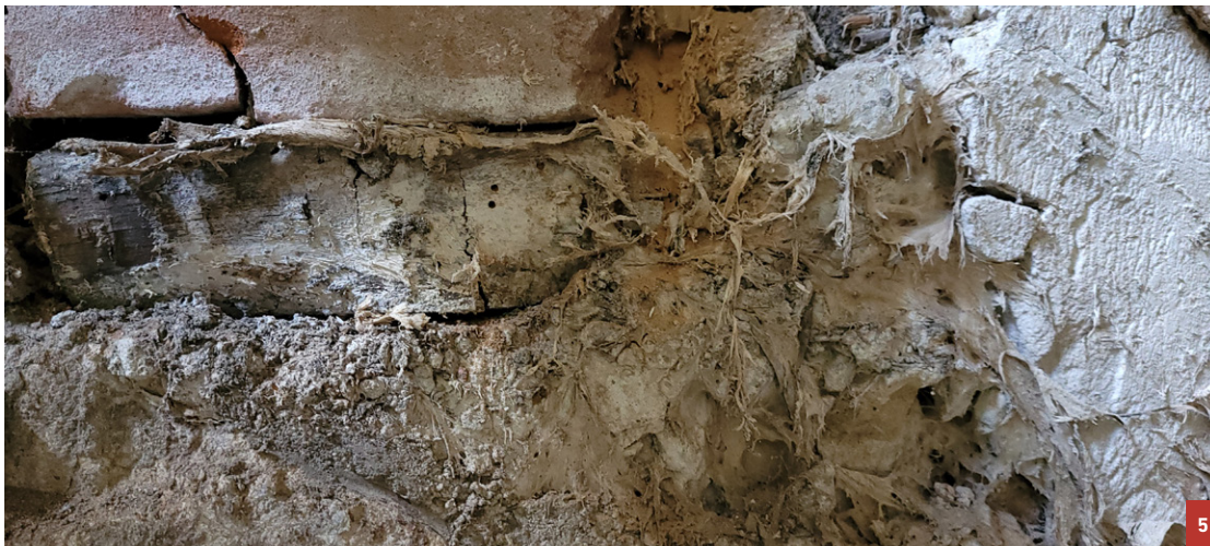
5 Grube sznury grzybniowe S. lacrymans na murze. Większość grzybni uległa atrofii. Fot. Bogusław Andres
